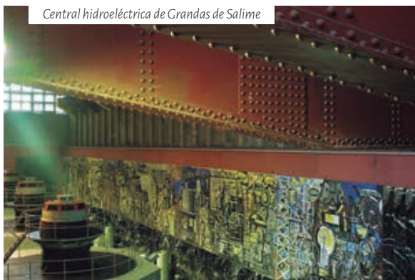
Central hidroeléctrica de Grandas de Salime
